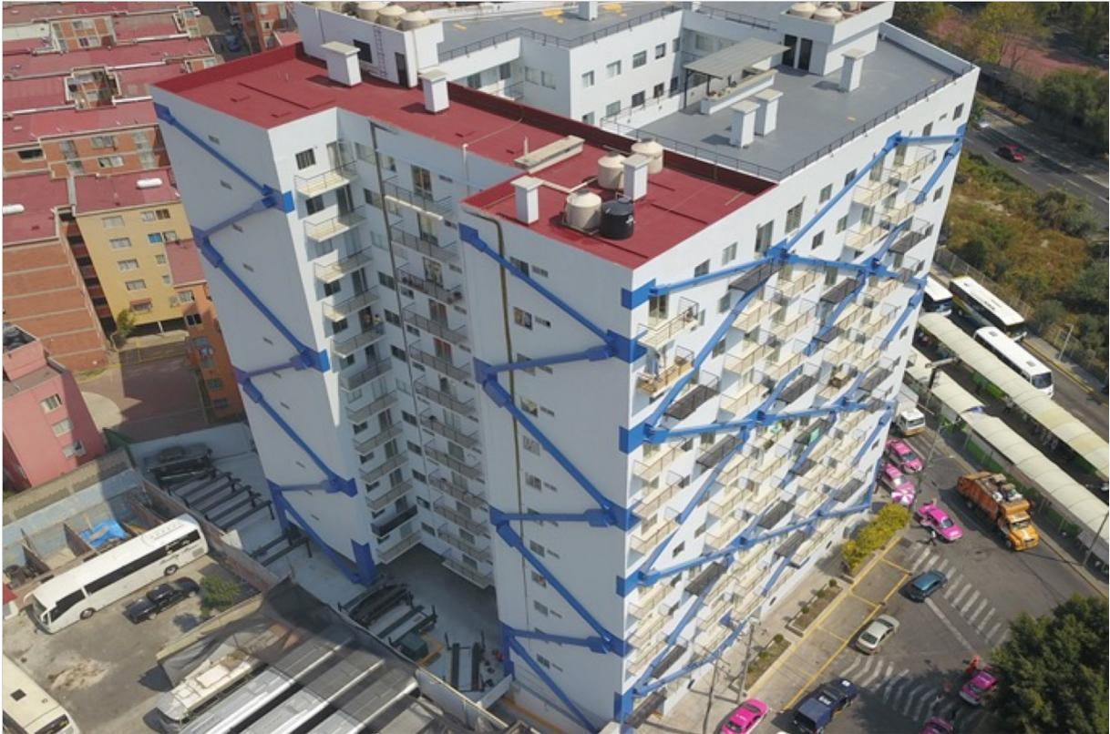
Figura 9. Uso de disipadores tipo Dampo 1505
