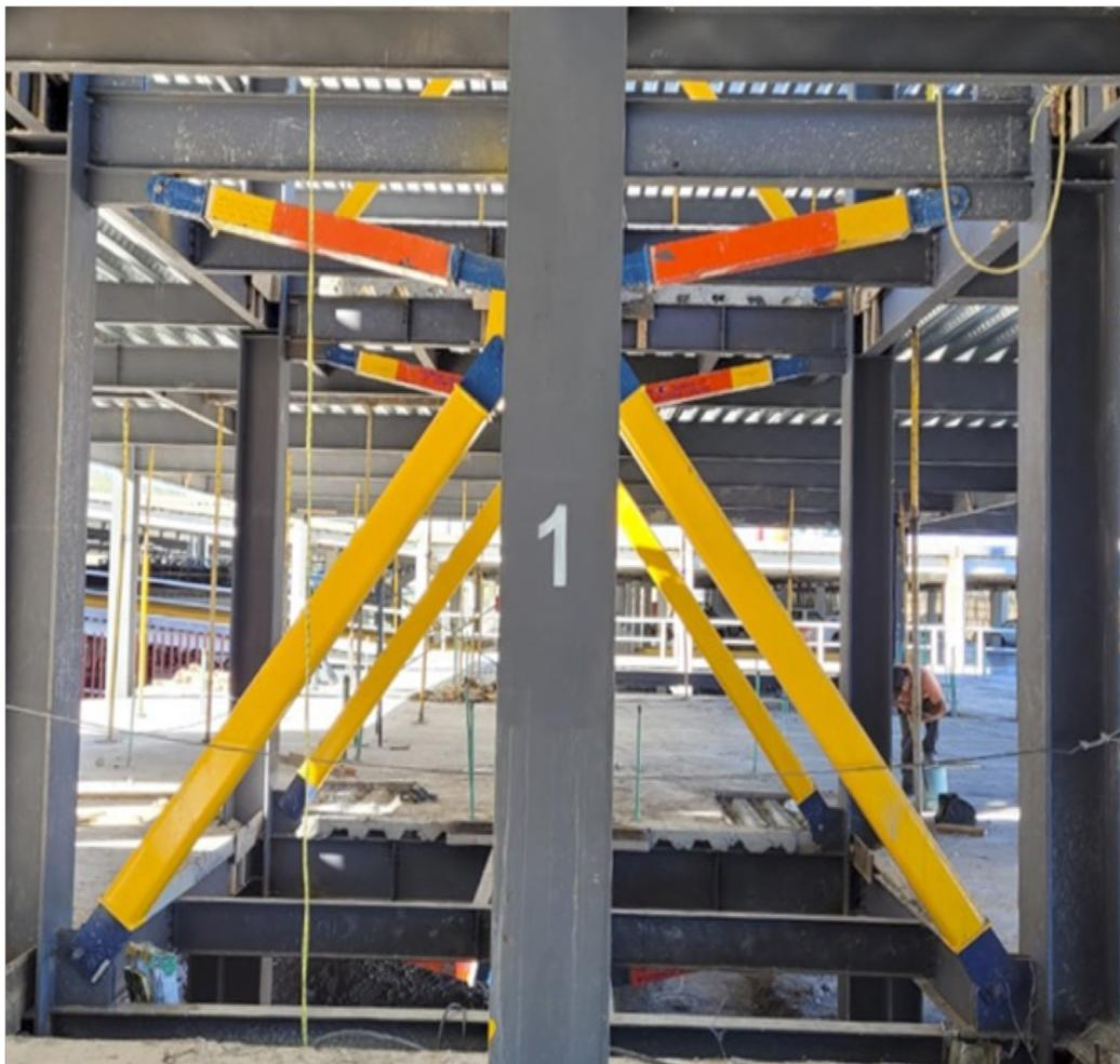
Figura 6. Uso de disipadores tipo Dampo BRB.
