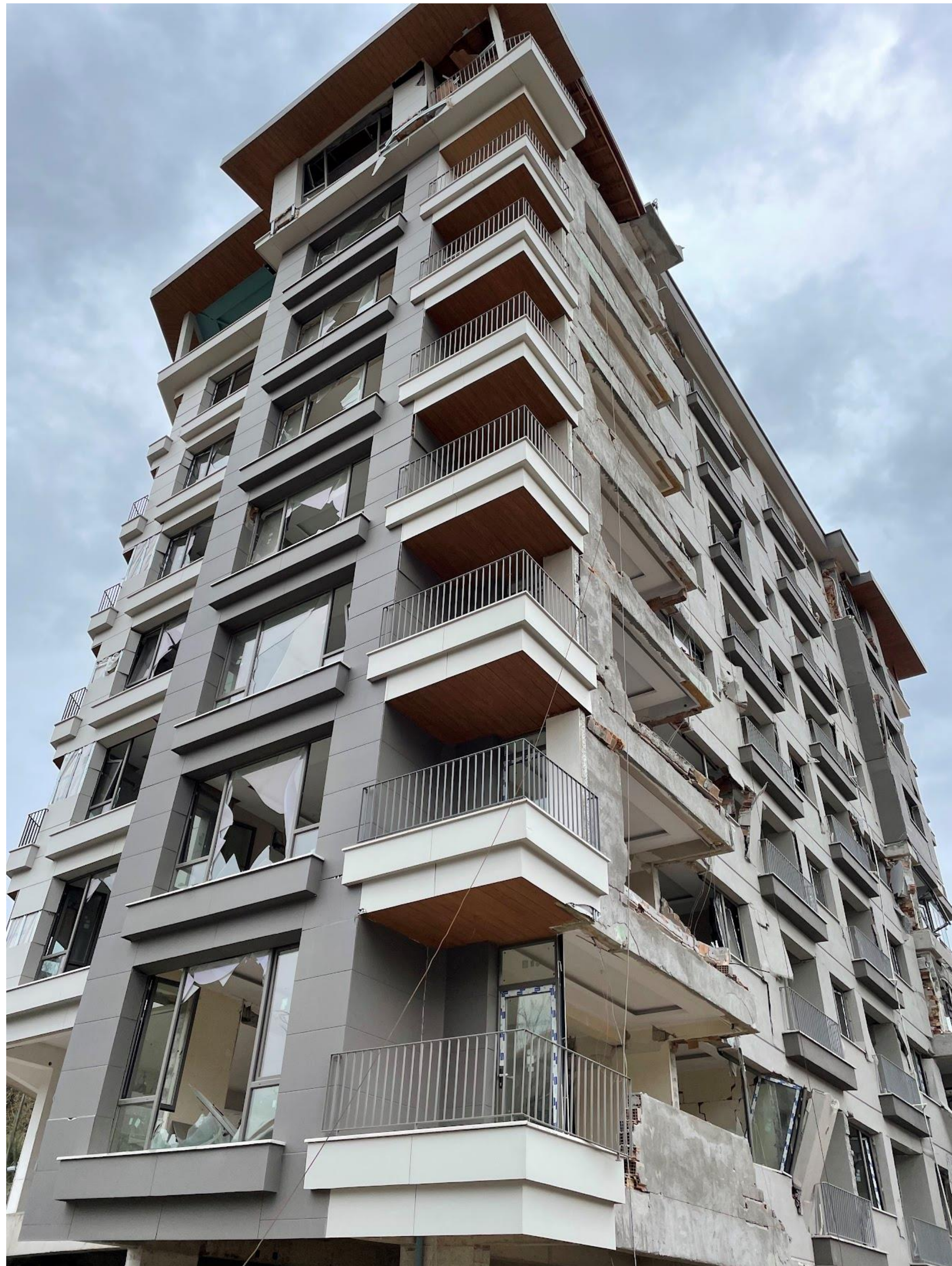
Hatay, Turquía, 2023. Daño en miembros estructurales. Edificio nuevo no puesto en servicio.
