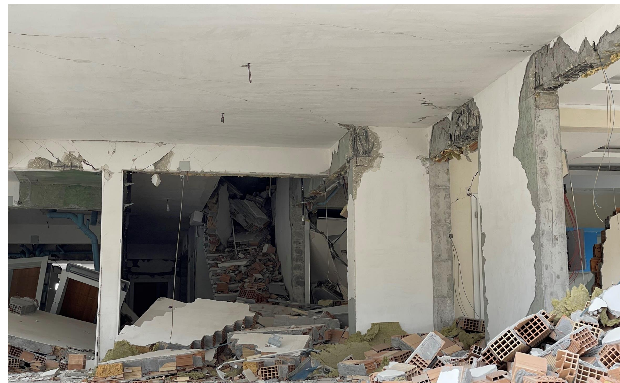
Hatay, Turquía, 2023. Daño en miembros estructurales. Edificio nuevo no puesto en servicio.
