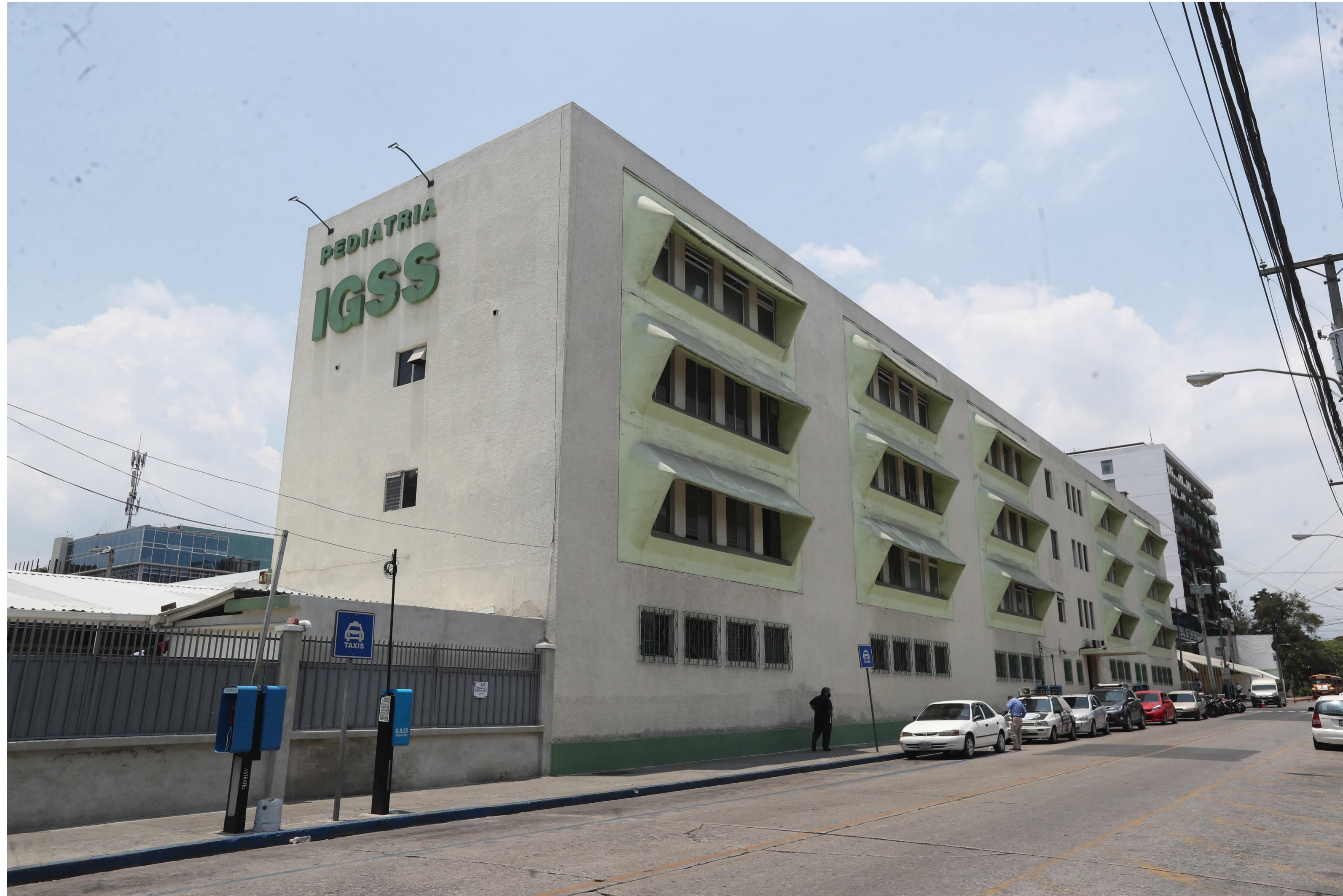
El Hospital de Pediatría del IGSS en la zona 9 de la Ciudad de Guatemala se construyó en 1968. Este dato se confirma al conmemorarse su 50 aniversario en 2018 ( IGSS Guatemala ).
