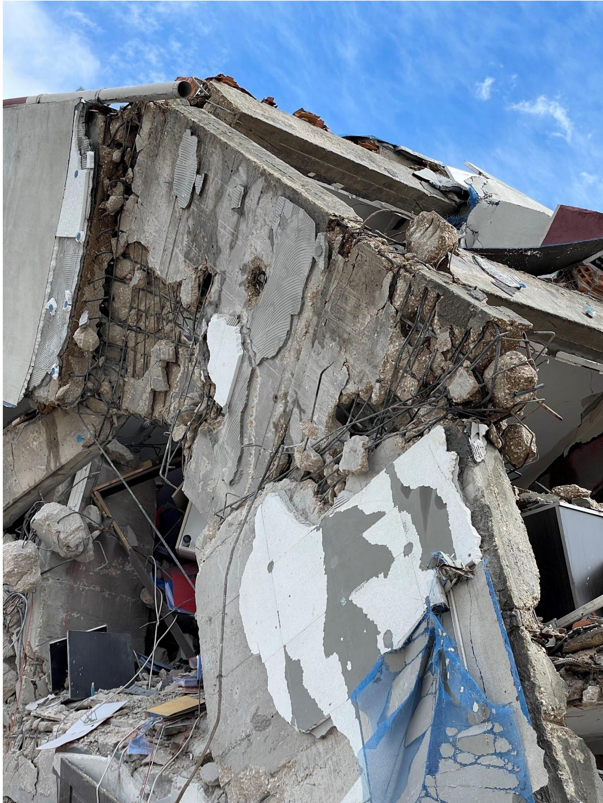
Hatay, Turquía, 2023. Daño en miembros estructurales de edificio colapsado.
