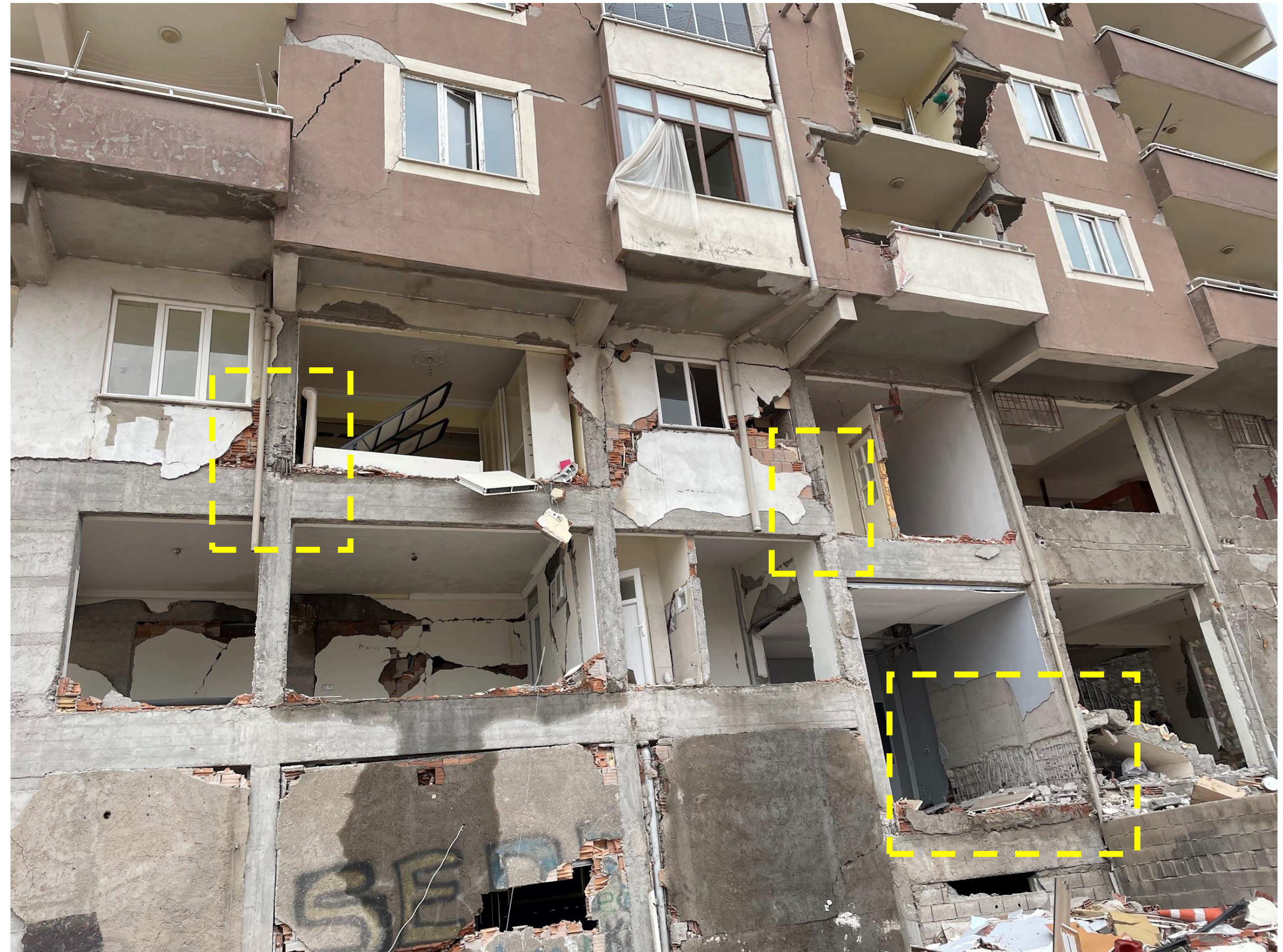
Kahramanmaraş, Turquía, 2023. Daño en fachadas de edificios.
